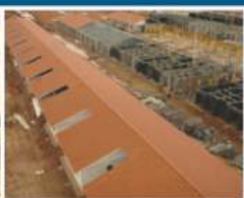
Obra em Pelotas-RS
