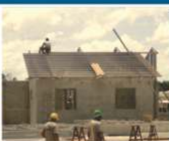
Obra em Pelotas-RS
