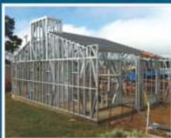
Obra em Porto Alegre - RS
