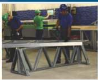
Fabricação Automatizada e Montagem dos Painéis
