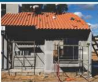
Obra em Porto Alegre - RS
