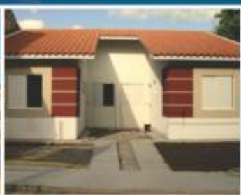
Obra em Santa Maria - RS
